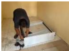
Gambar 12. Pemasangan rak buku
