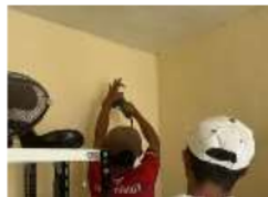
Gambar 13. Pemasangan kipas angin
