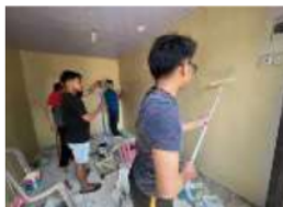
Gambar 10. Mengecat tembok pos baca
