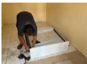
Gambar 12. Pemasangan rak buku
