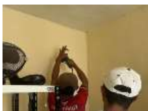
Gambar 13. Pemasangan kipas angin
