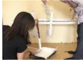
Gambar 17. Pengecatan rak dinding
