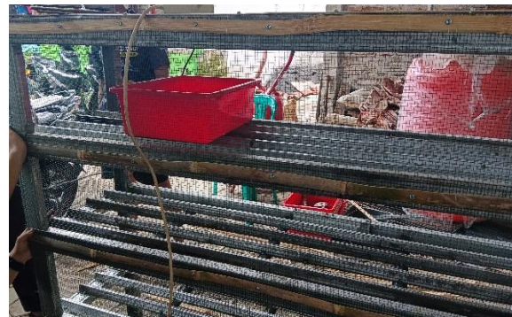
Gambar 10. Pemasangan Kawat Strimin.
