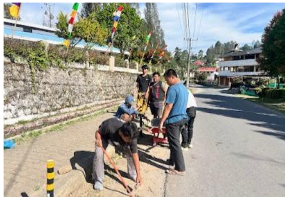
Gambar 5. Proses Pemasangan Reflektor Bambu di Jalan.
