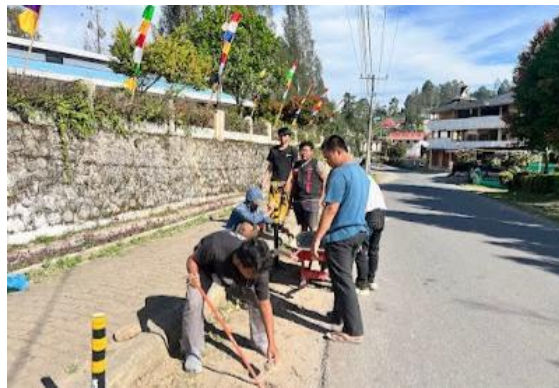
Gambar 5. Proses Pemasangan Reflektor Bambu di Jalan.
